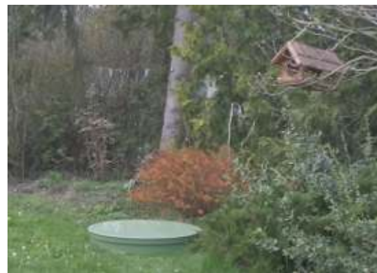
ČOV TOPAS S 5 po instalaci
